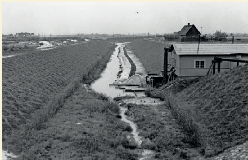
Ryc. 112 Fragment kanału. Na pierwszym planie prowizoryczna stacja pomp, 1935 r., Koncern Ilustrowany Kurier Codzienny - Archiwum Ilustracji (NAC, 1-G-4457-1)
