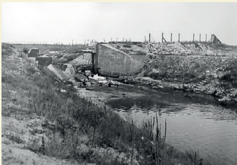
Ryc. 115 Wysadzony w powietrze przepust przy ujściu kanału do Wisły (Archiwum Państwowe w Warszawie, Biuro Odbudowy Stolicy, sygn. 7636)
