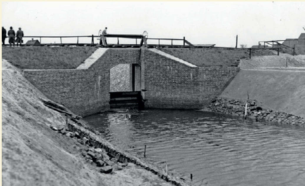
Ryc. 113 Śluza kanału odwadniającego. 1935 r., Koncern Ilustrowany Kurier Codzienny - Archiwum Ilustracji (NAC, 1-G-4457-2)
