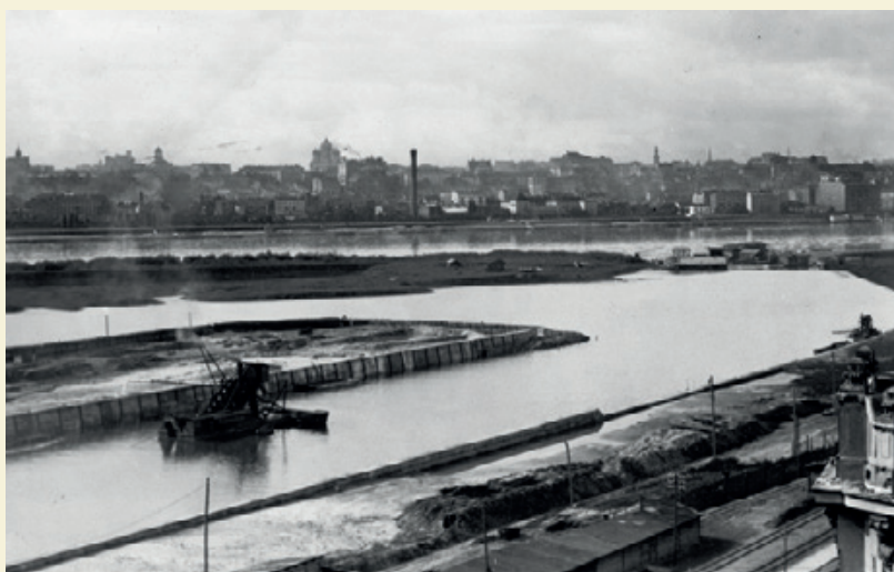
Ryc. 104 Port w trakcie budowy, Koncern Ilustrowany Kurier Codzienny - Archiwum Ilustracji (NAC, 1-G-4442)
