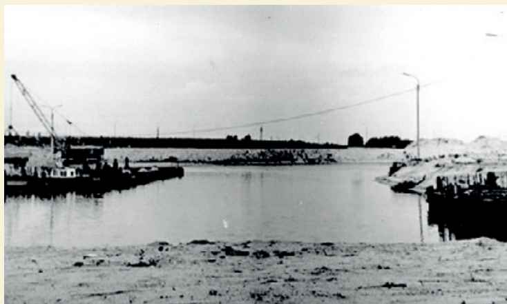
Ryc. 129 Basen portowy w trakcie budowy, 1963 r. (Archiwum Dokumentacji Osobowej i Płacowej w Milanówku, „Przedsiębiorstwo Państwowe Warszawska Żegluga na Wiśle”, sygn. 306)
