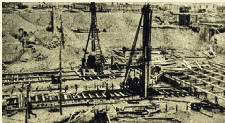
Ryc. 127 Budowa śluzy im. inż. T. Tillingera, „Stolica” nr 46, 1953 r.
