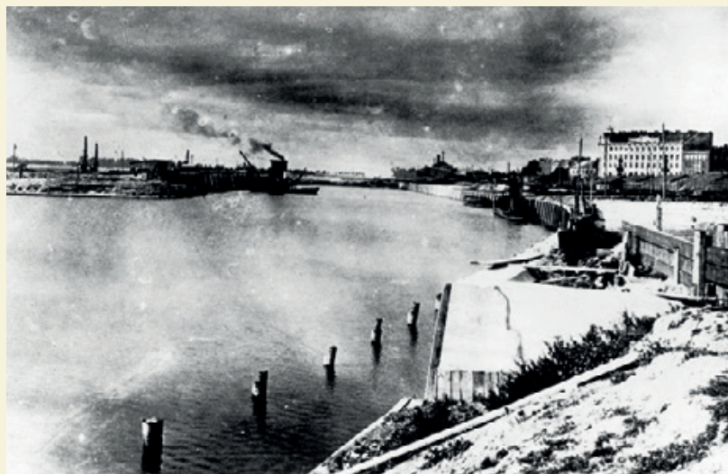
Ryc. 102 Basen nr 2 w trakcie budowy, Koncern Ilustrowany Kurier Codzienny - Archiwum Ilustracji (NAC, 1-G-4437)
