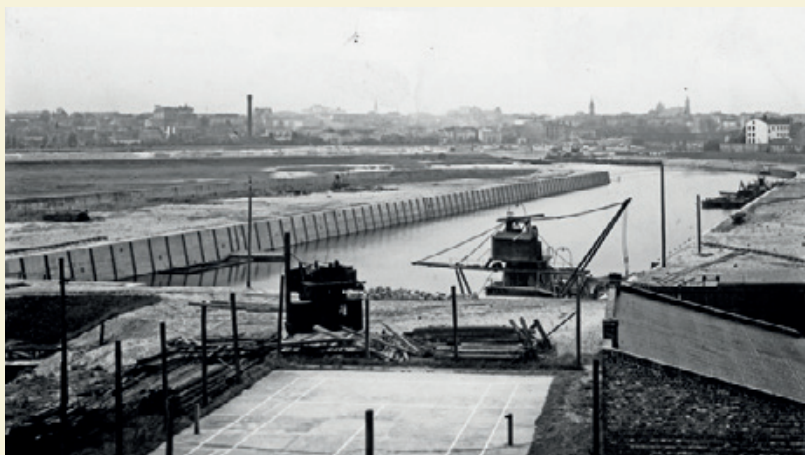
Ryc. 103 Basen nr 2 w trakcie budowy, Koncern Ilustrowany Kurier Codzienny - Archiwum Ilustracji (NAC, 1-G-4443)
