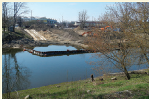
Ryc. 89 Budowa nowego slipu w Porcie Czerniakowskim, fot. A. Mistewicz, kwiecień 2017 r.
