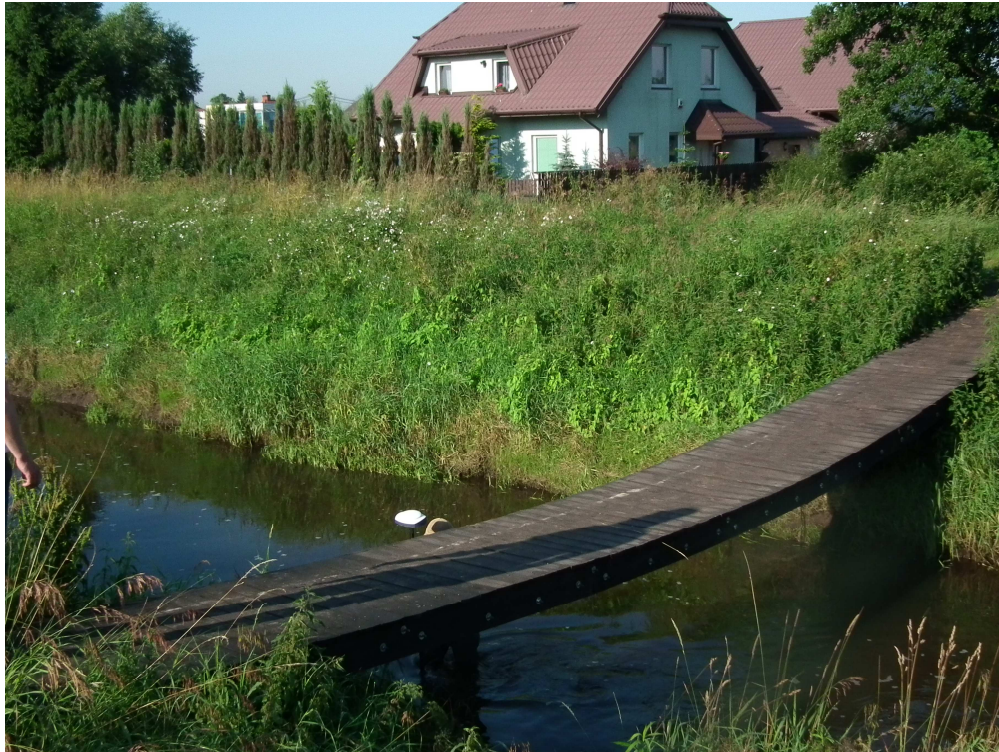
Foto 3 Tymczasowa kładka piesza w km 2+820 rzeki Długiej
