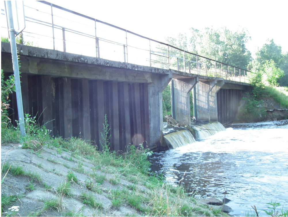
Foto 20 Ujście rzeki Długiej do Kanału Żerańskiego w postaci jazu – widoczna różnica poziomów wody pomiędzy rzeką a Kanałem, uniemożliwiająca migrację organizmów wodnych
