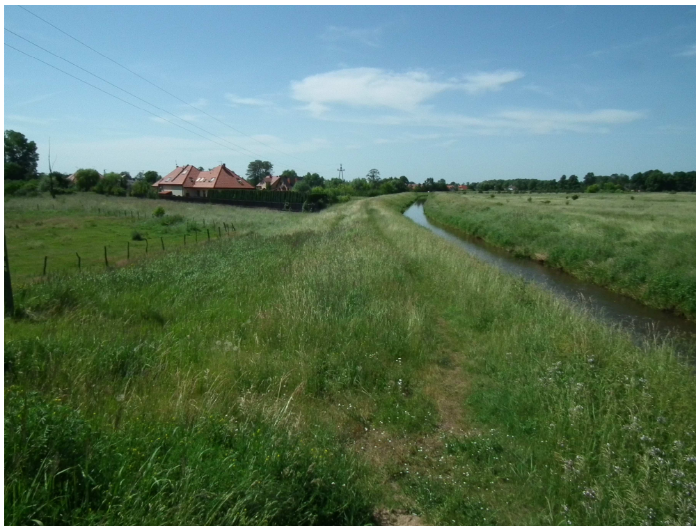
Foto 7 Zabudowa mieszkaniowa dochodząca do lewostronnego obwałowania rzeki, km 3+200÷3+300
