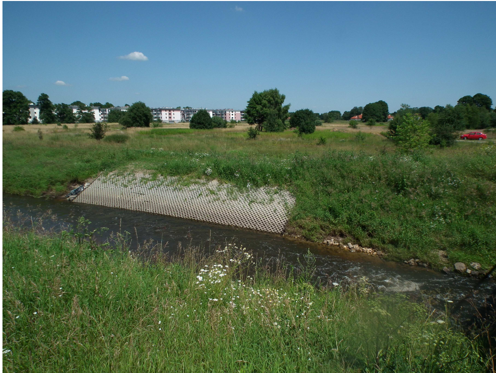
Foto 2 Rzeka Długa poniżej mostu w ciągu ul. Zdziarskiej, w tle nowo wybudowane osiedle mieszkaniowe na prawym brzegu rzeki
