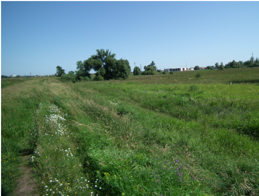
Foto 13 Lewostronne obwałowanie rzeki Długiej w rejonie km 3+500
