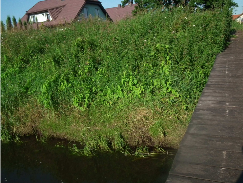
Foto 14 Wał przeciwpowodziowy pokryty łanami pokrzywy zwyczajnej w rejonie kładki dla ruchu pieszego w rejonie km 2+800 rzeki Długiej
