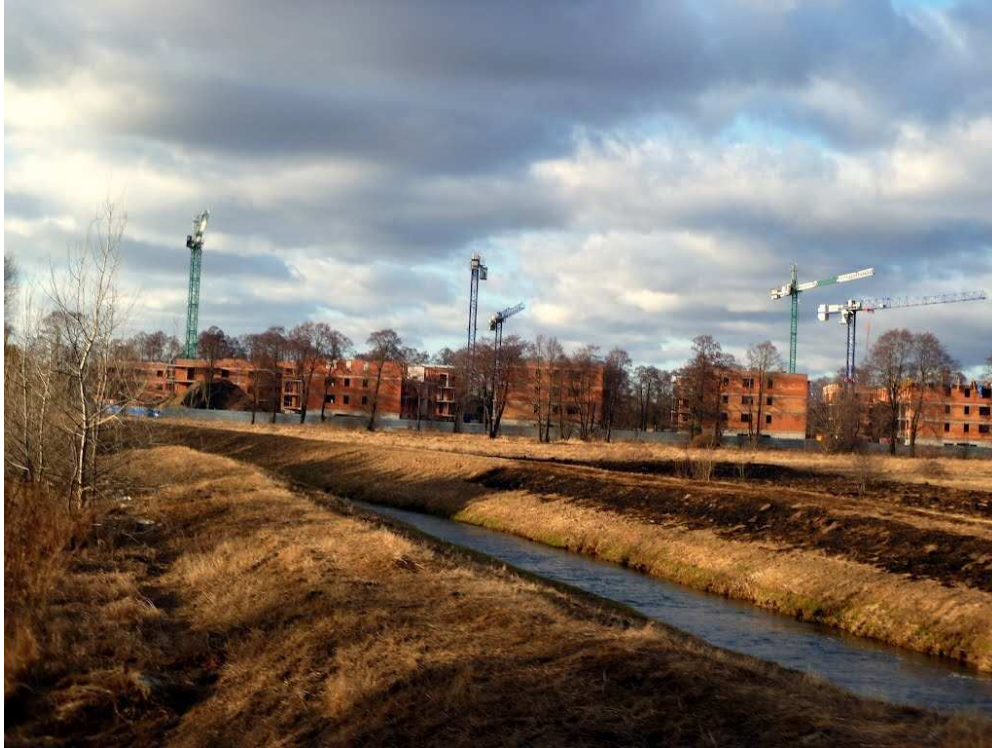
Foto 19 Budowa osiedla mieszkaniowego na prawym zawału rzeki Długiej pomiędzy mostami na ul. Zdziarskiej i Ostródzkiej; na pierwszym planie obwałowane koryto rzeki Długiej
