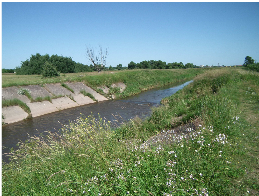
Foto 18 Umocnienia koryta rzeki w miejscu stopnia w km 3+539
